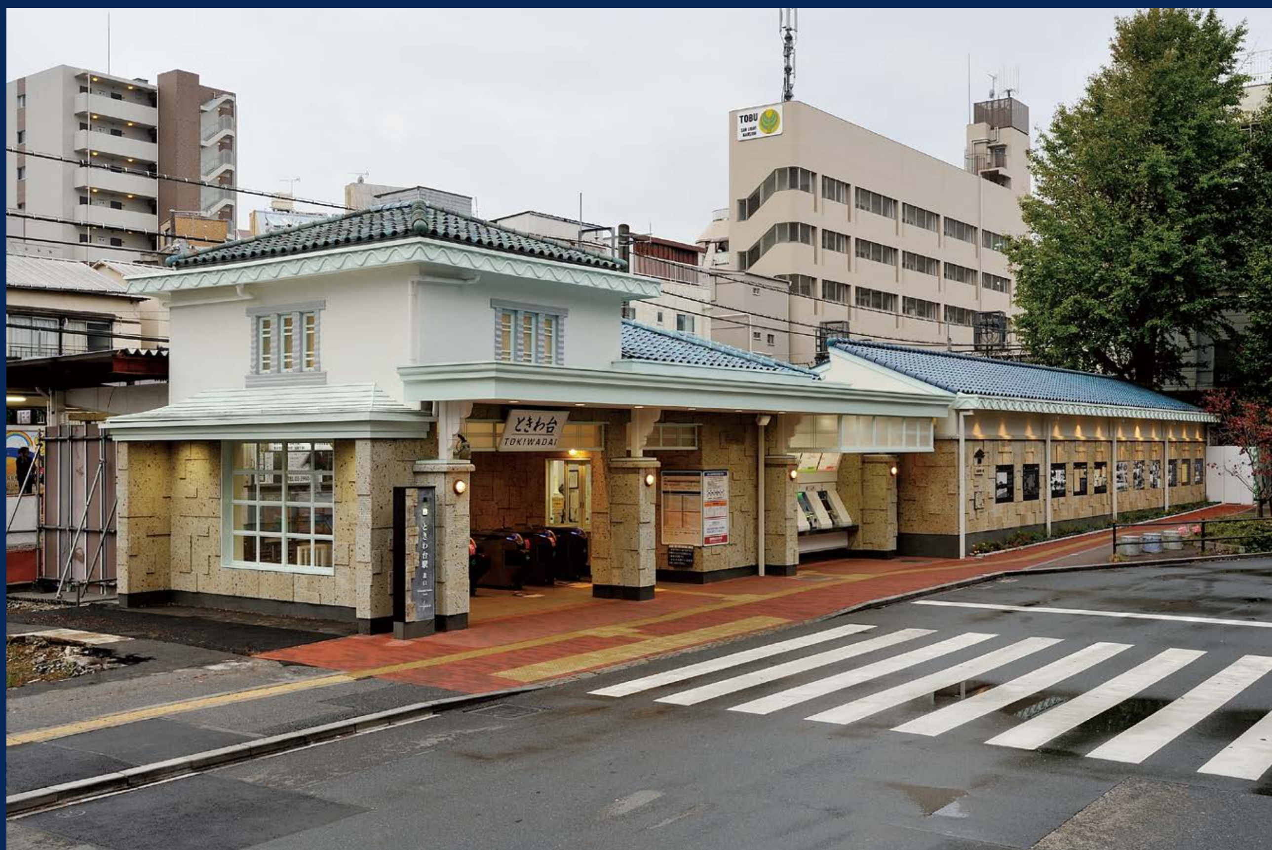
ときわ台駅舎（2018 年改修）
